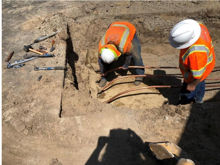
Trabajadores instalando líneas de servicio de cobre para un nuevo desarrollo
